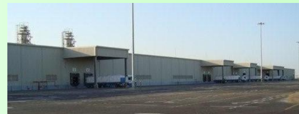
ペトロ・ラービグ社工場構内倉庫
